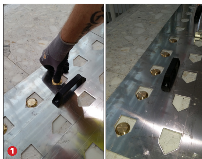
Skabeloner til placering af elementer og nitter letter og sikrer installationen.
